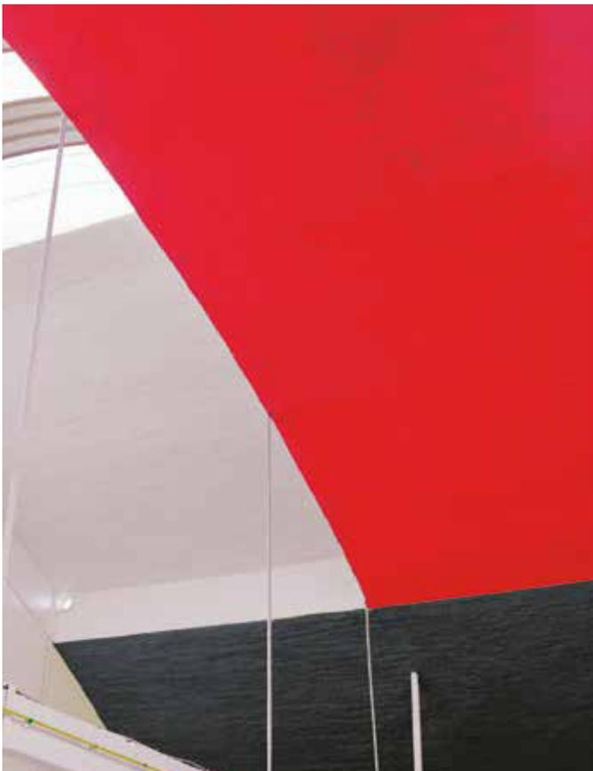
Solution thermique, incendie par Fibrexpan® avec finition Sidairless®.
