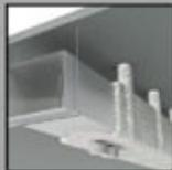
Protection incendie de conduit tôle rectangulaire de ventilation et de désenfumage horizontal et vertical par Firespray®
